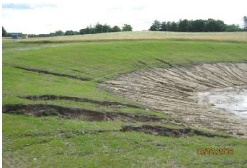
Figur 4: Nyt bassin med dybe skyllerender
